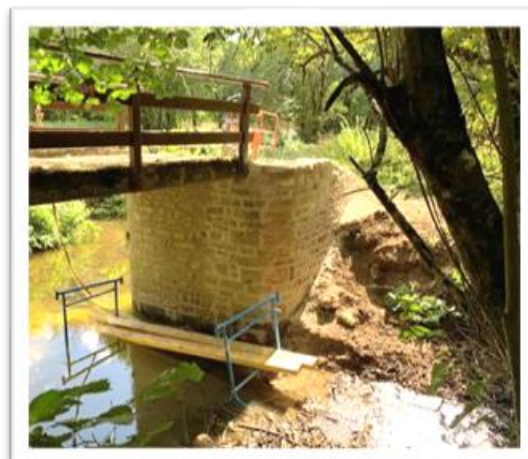
Passerelle après travaux
