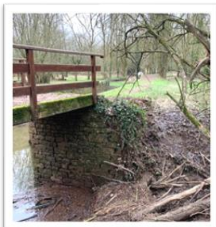
Passerelle avant travaux
